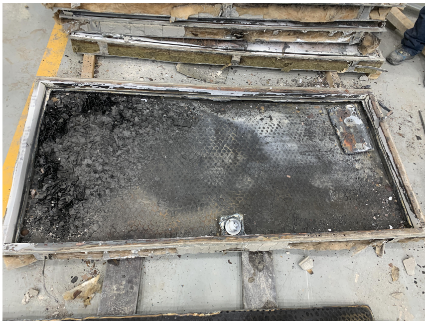
< 가열종료 후 시험체 내부 >
